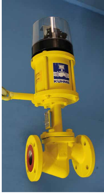
Abb. 9: Gas-Sicherheitsabsperreinrichtung: Vorher – Nachher (Quelle: KÜHME Armaturen GmbH)
